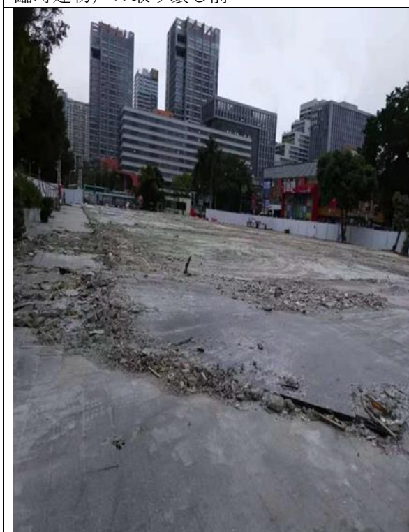
3、撤去完了後の現場
